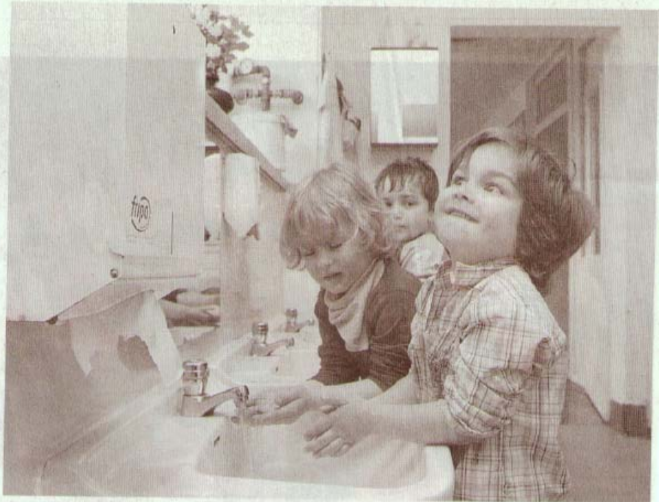
Längst nicht alle Kitas im Kreis verfügen bereits über moderne Sanitäreinrichtungen.
